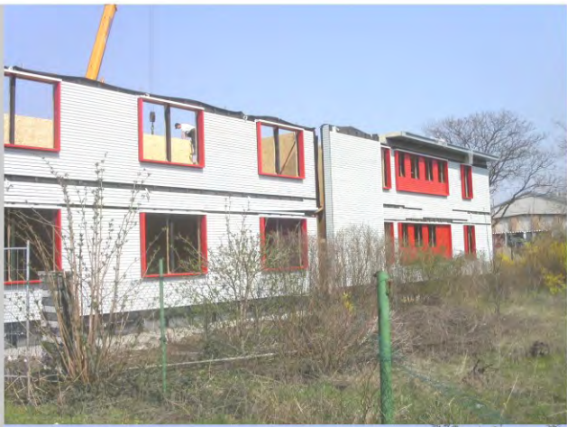
U2-6 Montage der Fertigteile
